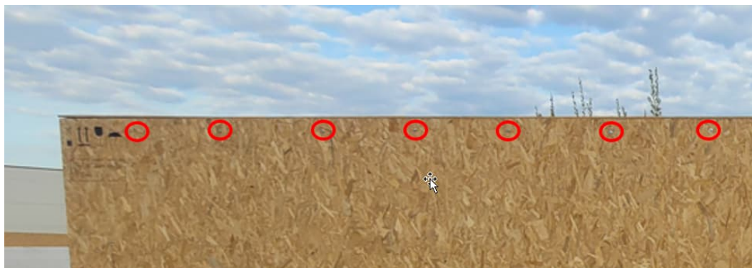
Abbildung 7: Schrauben der Deckelhölzer
